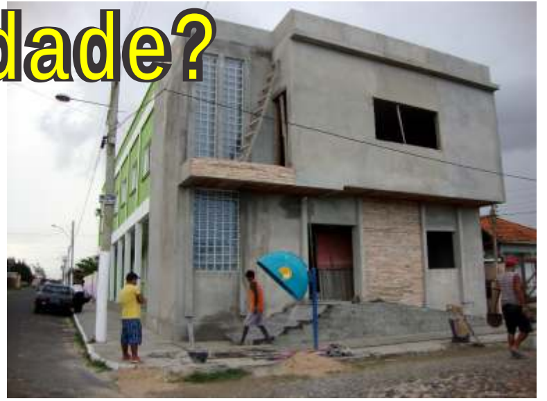
Obras da Câmara não respeitam a Lei da Acessibilidade.
