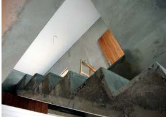
A Escada que dá acesso à plenária exclui algumas pessoas.
